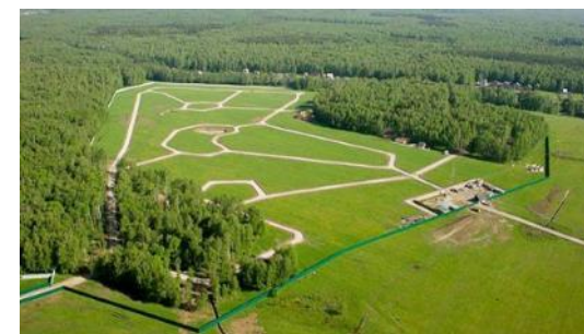
ЗЕМЕЛЬНЫЕ УЧАСТКИ / СТРОИТЕЛЬСТВО
